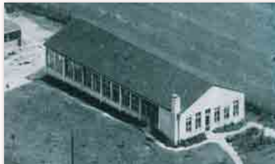
Neubau I: Es geht steil bergauf mit dem Betrieb. Nur fünf Jahre nach der Gründung bezieht das Unternehmen ein neues Gebäude in der Erdmannhäuser Straße 57 in Marbach, wo es heute noch angesiedelt ist.
